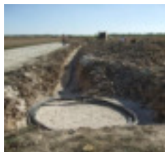
Pose de réseaux HTA
