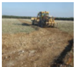
Décapage pour câblage
